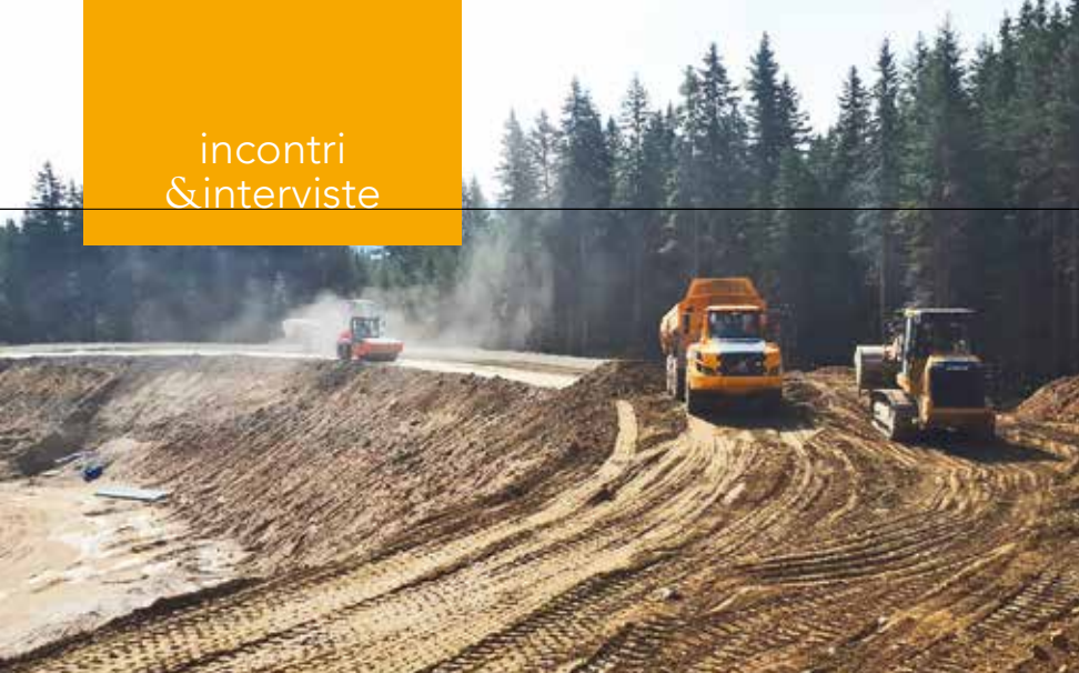
7. La predisposizione della strada di coronamento del bacino con stabilizzazione del terreno
