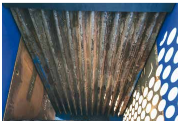
14. La bocca di carico di frantumazione delle materie prime
