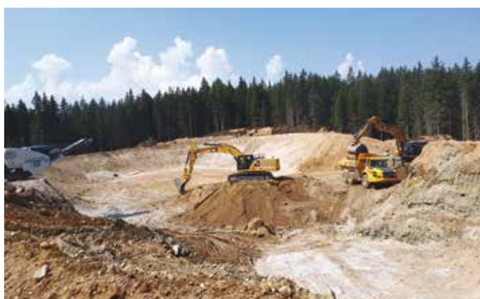
3. Il cantiere di scavo per il bacino d'innevamento d'alta montagna
